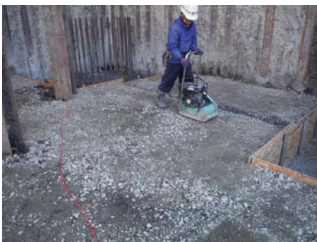
写真 6.8.2-7 再生碎石利用
