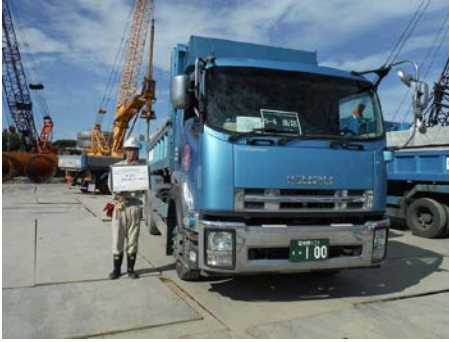
写真 6.8.2-1 建設汚泥再資源化施設搬出
