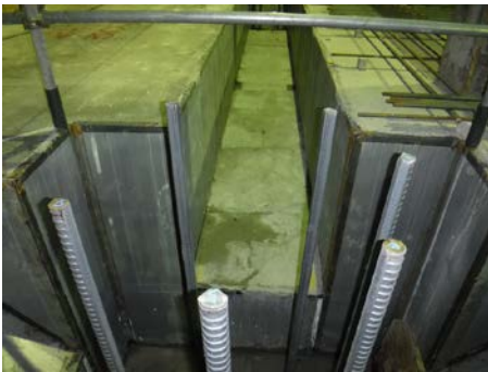
写真 6.8.2-5 鋼製型枠
