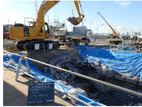
写真 6.8.2-2 コンクリート塊分別収集
