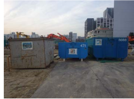
写真 6.8.2-4 廃棄物分別コンテナ設置
