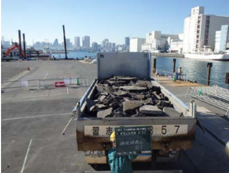
写真 6.8.2-3 アスファルト塊分別収集
