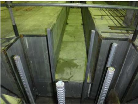
写真 6.8.2-5 鋼製型枠
