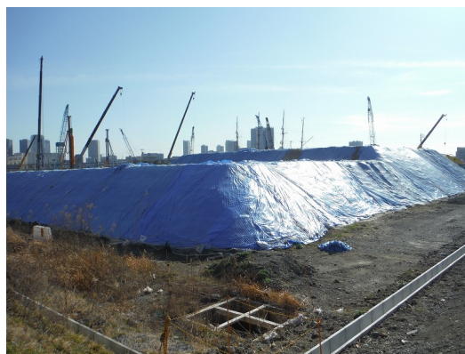
写真 6.8.4-1 シート養生の状況
