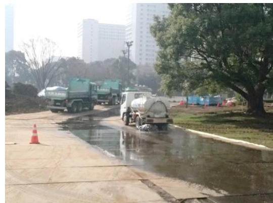
写真 8.1-14 散水車による鉄板上の散水
