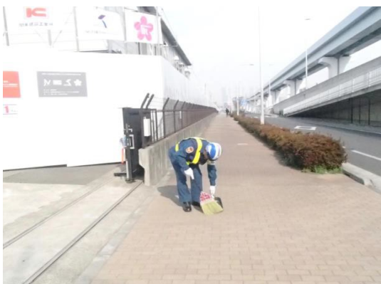
写真 8.1-7 歩道清掃の状況
