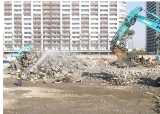
写真 8.1-12 解体時の散水
