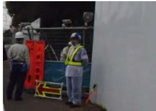
写真 8.12-4 歩道占用工事での歩行者安全対策
