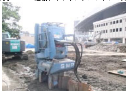
写真 8.5-8 サイレントパイラー工法
