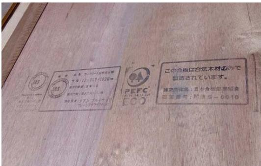
写真 8.9-7 コンクリート型枠合板
