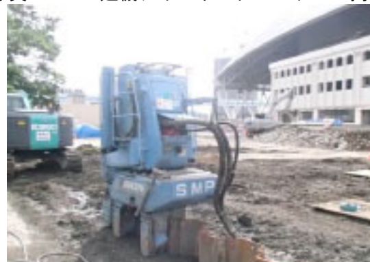
写真 8.5-8 サイレントパイラー工法
