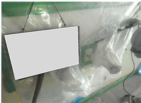
写真 8.8-3 アスベスト除去
