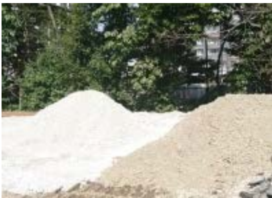
写真 8.8-5 再生碎石利用（現場内ストックヤード）
