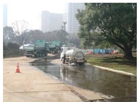
写真 8.1-14 散水車による鉄板上の散水
