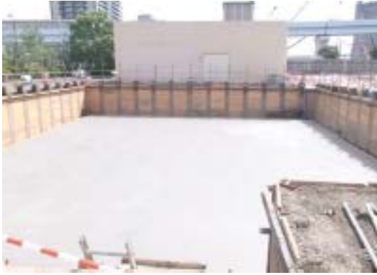
写真 8.9-3 リサイクル材料 (均しコン(再生骨材)を用いたコンクリート))
