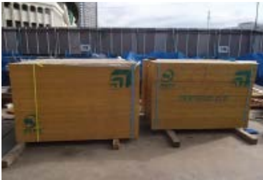
写真 8.9-5 コンクリート型枠合材
