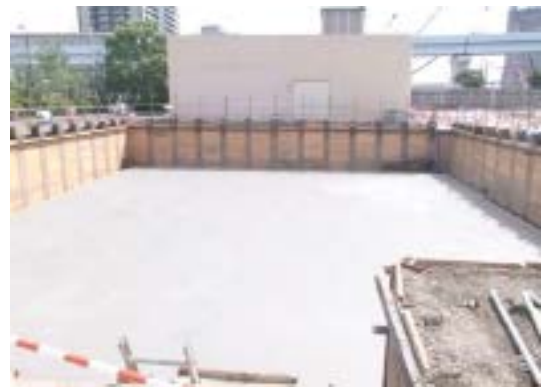
写真 8.8-6 リサイクル材料 （均しコン（再生骨材Lコンクリート））
