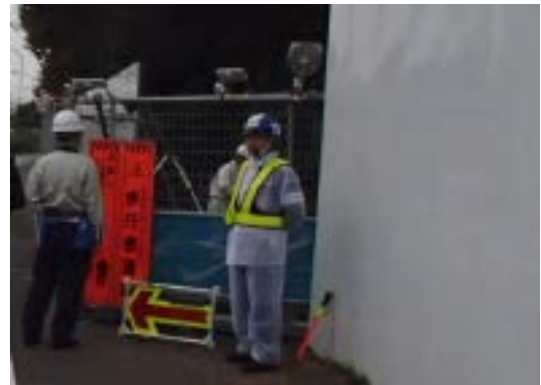
写真 8.12-4 歩道占用工事での歩行者安全対策
