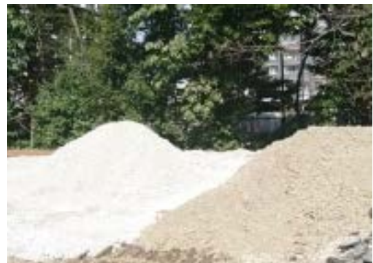
写真 8.9-2 再生碎石利用（現場内ストックヤード）
