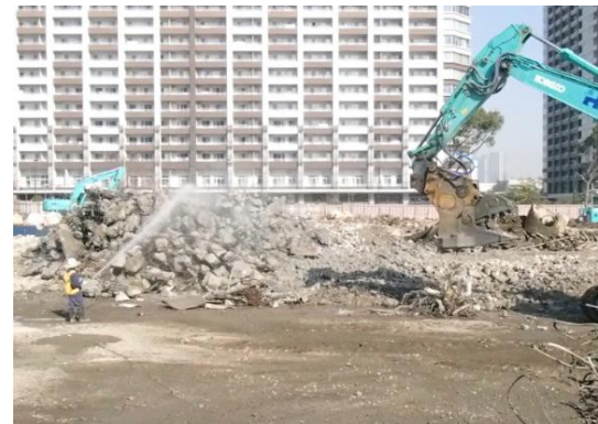
写真 8.1-12 解体時の散水
