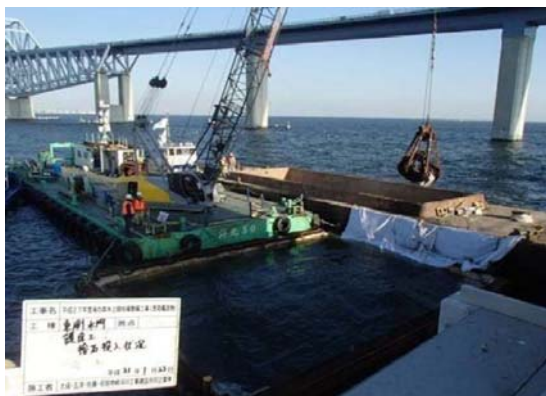
写真 8.2-1 汚濁防止膜使用時（捨石工）
