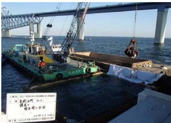
写真 8.2-1 汚濁防止膜使用時（捨石工）
