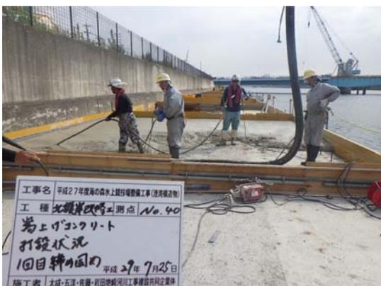
写真 8.10-7 再生骨材コンクリート
