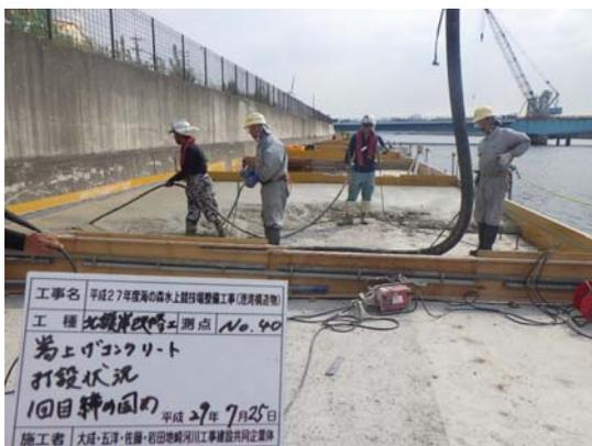
写真 8.11-1 再生骨材コンクリート
