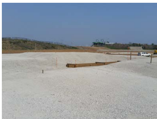
写真 8.4-1 再生クラッシュラン使用状況
