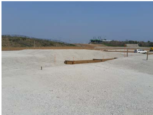
写真 8.4-1 再生クラッシュラン使用状況
