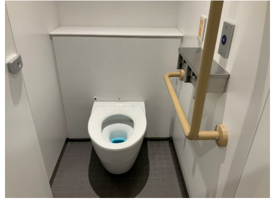
写真 9.1.5-2 節水型トイレ（新国立競技場）
