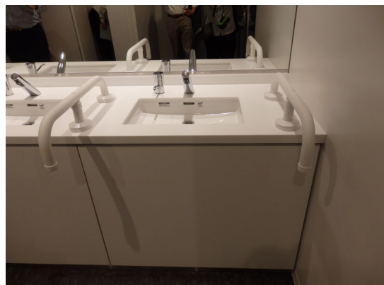
写真 9.1.5-8 自動水栓（武蔵野の森総合スポーツプラザ） （東京都撮影）
