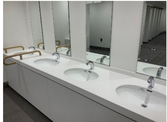
写真 9.1.5-4 自動水栓（新国立競技場）
