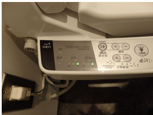
写真 9.1.5-7 擬音装置付き節水型トイレ（武蔵野の森総合スポーツプラザ） （東京都撮影）
