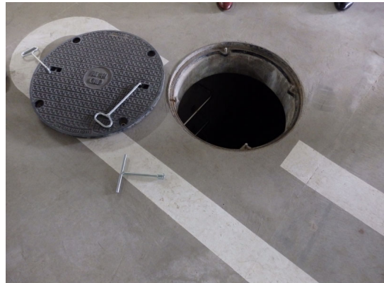
写真 9.1.5-6 雨水貯留槽（武蔵野の森総合スポーツプラザ） （東京都撮影）
