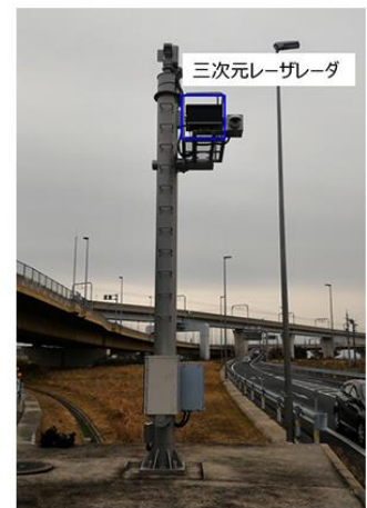
図3：三次元レーザレーダ設置状況
