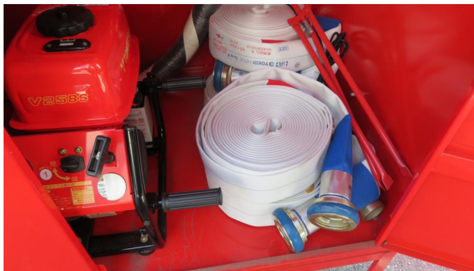
動力消防ポンプ設備
