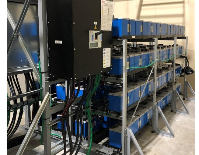
大型UPSの例
