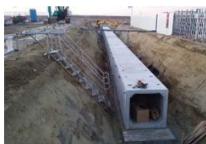
石巻市 新門脇地区 下水道雨水災害復旧事業
