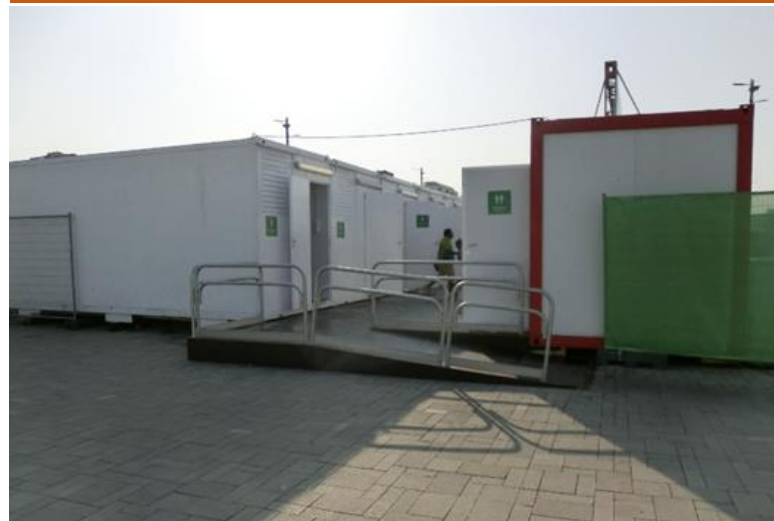
仮設トイレ(ユニットハウス)の例
