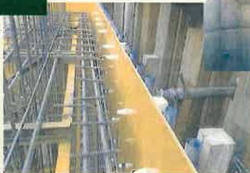
橋台 (国産材型枠)
