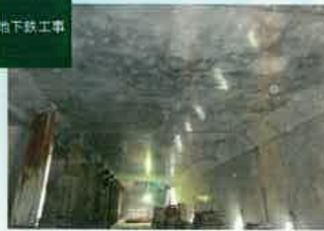
ボックスカルバートの天井部分
