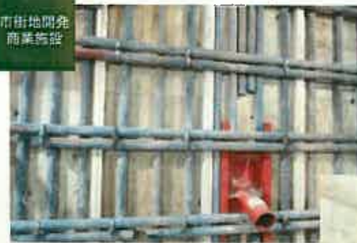
地下1階の内壁建て込み
