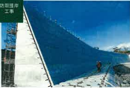
防潮護岸完成
