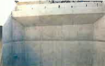
国産材型枠のコンクリート表面
