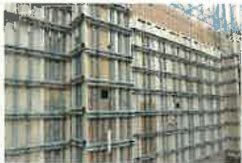
外壁の建て込み状況
