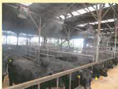
ミストの噴霧と換気扇による 畜舎の冷却
