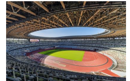
大屋根トラスへの木材活用
