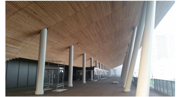
木材を使用した有明体操競技場の外装
