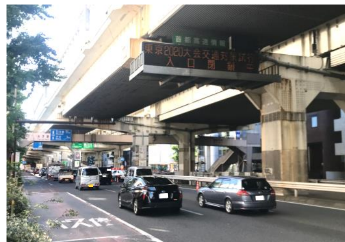
入口閉鎖(国道246号 三軒茶屋入口周辺)
